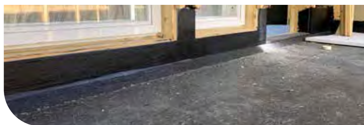
Vanntetting av OSB/CLT prefabrikkert balkong
