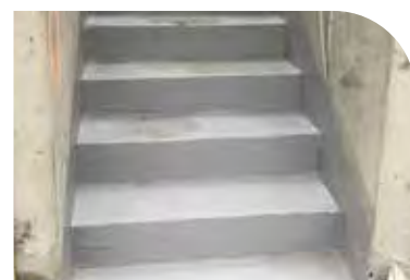
Nylagde trapper før behandling med PU-Sealer
