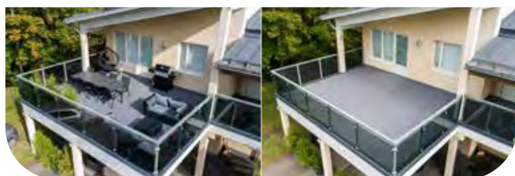
Takterrasse ElaProof + SAND belagt - med og uten møbler.
