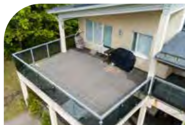
Takterrasse før oppussing
