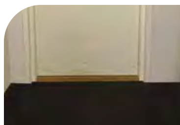
Gulv i teknisk rom
