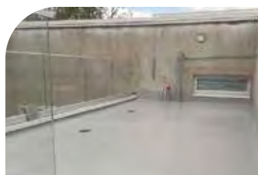
Takterrasse behandlet med ElaProof
